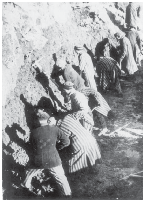
Prisonniers effectuant des travaux de terrassement.
