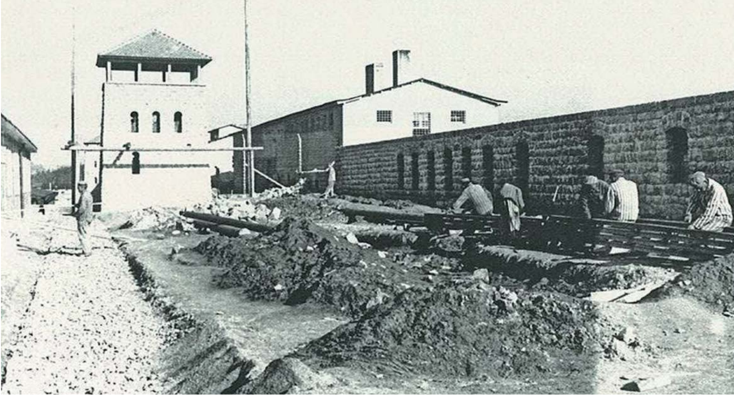
Chantier durant la construction du nouveau Revier, Mauthausen 1942 ou 1943.
