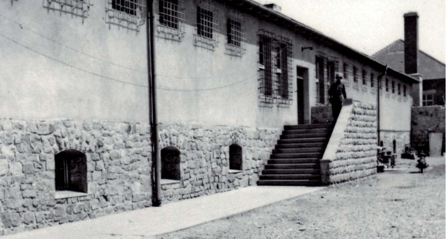
Entrée du bunker du côté de la cour.
