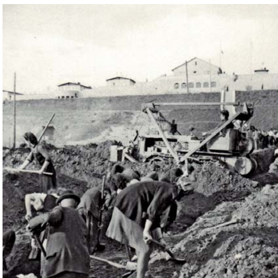
Civils creusant des fosses communes sur l'ancien terrain de sports des SS, mai 1945.
