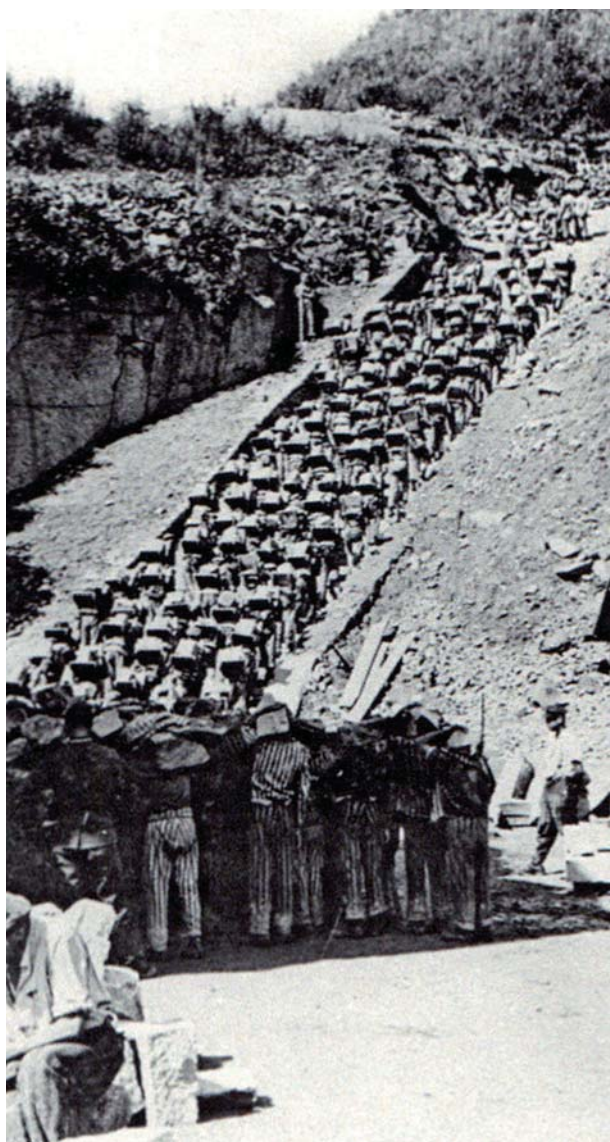
Détenus chargés de transportés des pierres gravissant « l'escalier de la mort » dans la carrière, entre 1942 et 1944.
