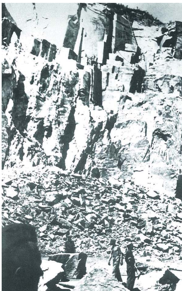
Détenus au travail dans la carrière. Après chaque dynamitage, les détenus trient les pierres destinées à être taillées. Celles-ci sont ensuite alignées et taillées avant d'être montées au camp par l'escalier de 186 marches
