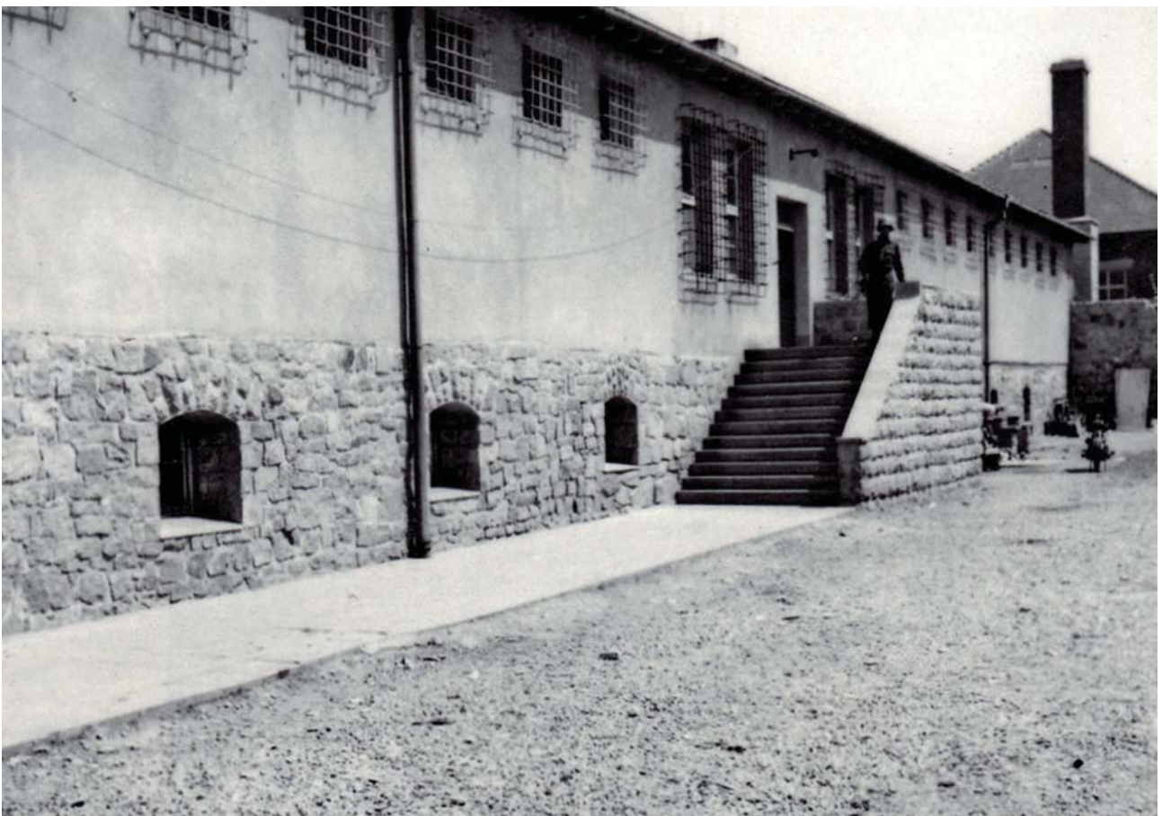
Entrée du bunker du côté de la cour.
