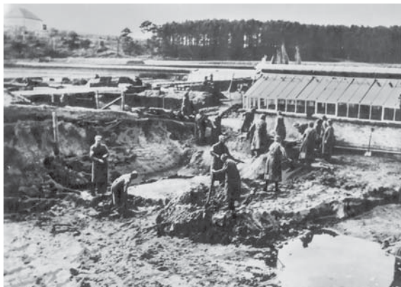
Des prisonnières sont employées pour des travaux de terrassement et d'extension du camp.
